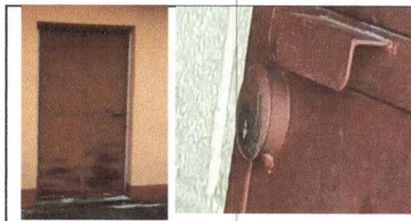
**FOTO 6 :** Mantenimiento a estructura (lijado, cambio de tubo , cepillado, sujeciones, aplicación de pintura) y Sustitución de chapa en aulas y Sustitución de chapa
