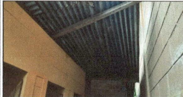
**FOTO 1:** Sustitución de lámina, por lámina troquelada aluzinc calibre 26 y Sustitución de estructura de soporte de madera, por metal. Sanitarios
