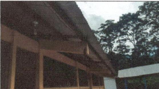
FOTO 9: Sustitución de canal de metal y Reparación de bajada de agua pluvial, tubo PVC 3"
